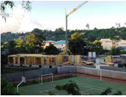
Montage structure - 28 avril
